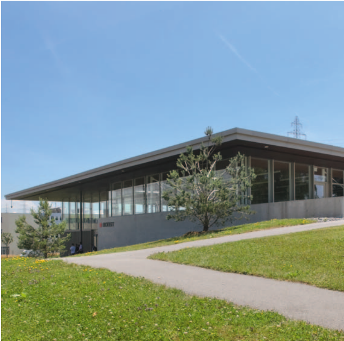
Restaurant du site de Mex, Suisse, construit selon les principes mêmes du développement durable.
